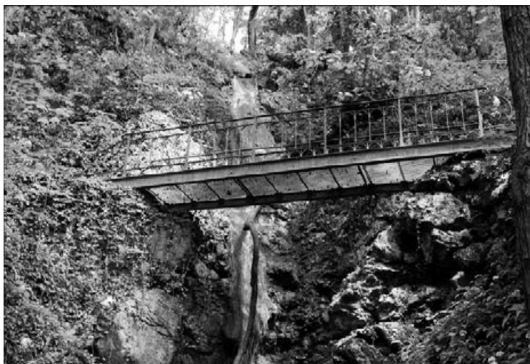
Abbildung 4: Teufelsbrücke im Schlosswäldli beim Schloss Neu-Bechburg Bild: G. Bürgin
