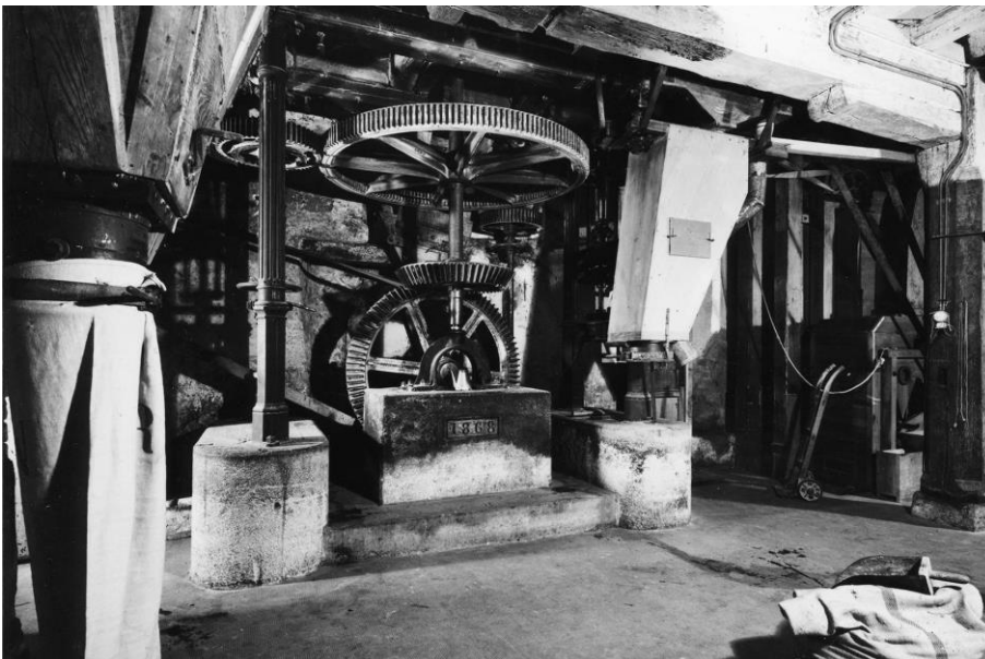
Mühle Hirslanden, Kegelgetriebe von 1868 im Keller. Foto Baugeschichtliches Archiv Zürich 1967
